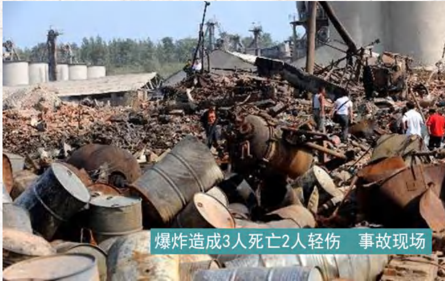
辽宁金航石油化工发生爆炸事故。原因是当班操作工违章脱岗，反应失控时没能及时发现和处置。
