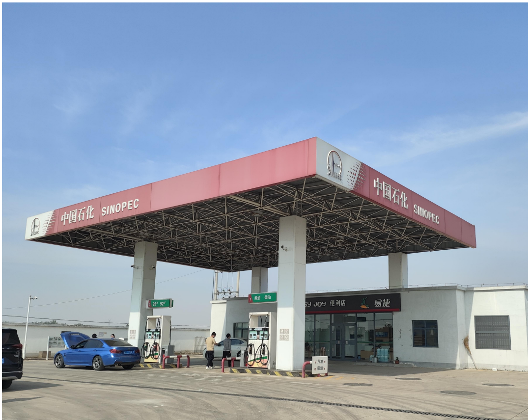
图 2-1 涡阳县盛磊石油化工有限公司林场加油站外观图
